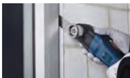
Ⓖ弾性シーリング除去作業
