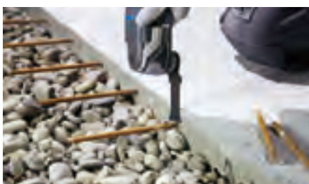
Ⓖ鉄筋の面一切断
