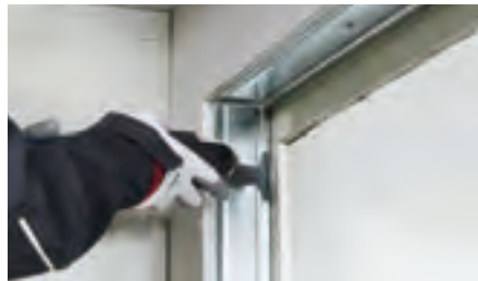
Ⓔドア開口作業
