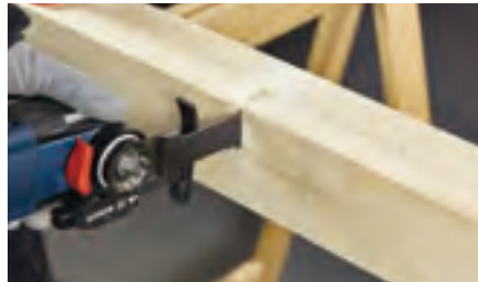
Ⓑ柱のほぞ切り(深さゲージ使用)
