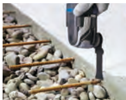
鉄筋面一切断
