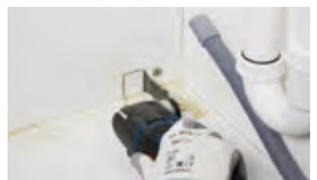
Ⓖボードのポケット切断
